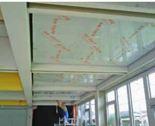
Bild: Sperber Ingenieurgesellschaft
