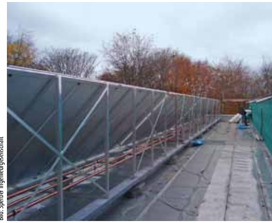
9 Die Solaranlage mit einer Fläche von 58 m 2 wurde mit einer Neigung von 45° auf dem Flachdach montiert.
