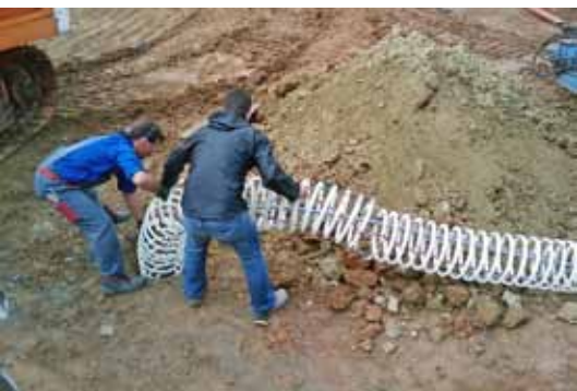
8 Als Wärmequelle für die Sole/Wasser-Wärmepumpen wurden 9 m tiefe Sonden mit spiralförmig angeordnetem Kunststoffrohrabsorber (25 × 2,3 mm, Gesamtlänge 40 m) installiert.
