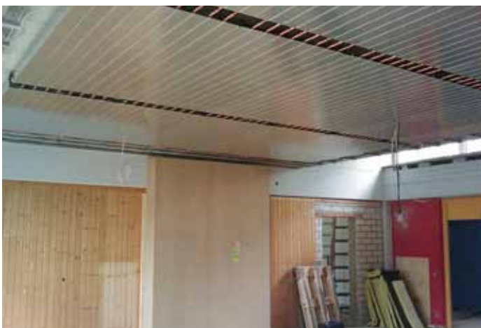
Bild: Sperber Ingenieurgesellschaft
